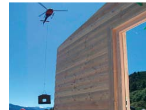
Holzbau auf 2500 Meter Seehöhe.
